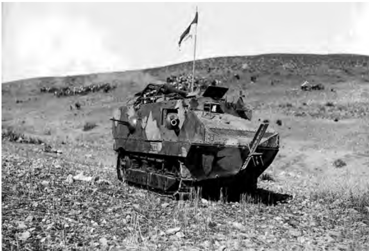
Imagen 11.- Vista del costado derecho del Schneider ARTILLERÍA Nº 4 . Se aprecian tanto el obús como la ametralladora de ese costado.
