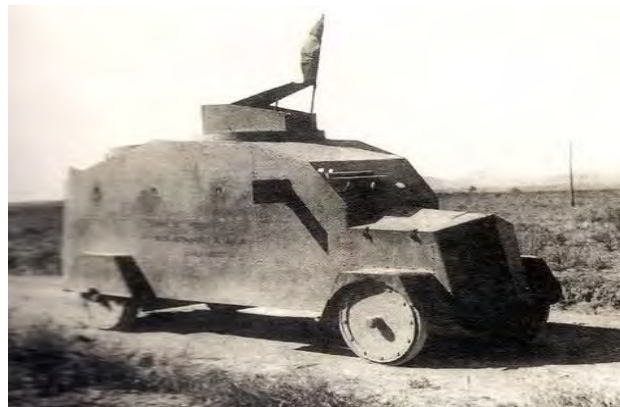
Imagen 2.- El primer "Camión Protegido" recibido en Melilla fue uno de los cinco realizados sobre chasis Nash-Quad, como el de la fotografía,
